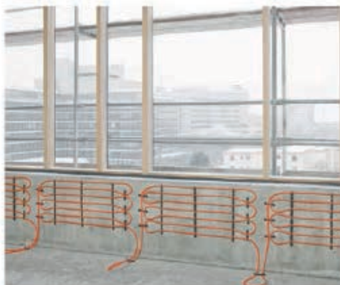
Zidno grejanje i hlađenje u mokrom postupku gradnje: Korišćenje zidnih površina za potrebe grejanja i hlađenja omogućava višestruka sistemski rešenja kod energetski efikasnih sistema.
